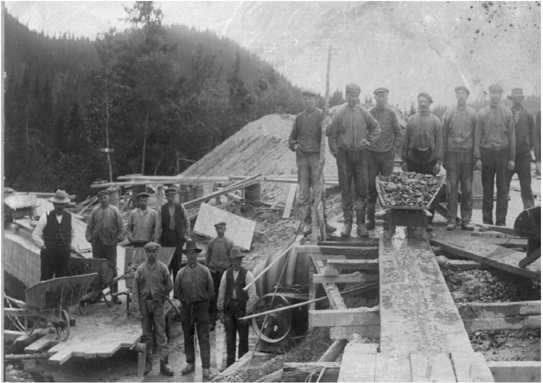
Fra byggingen av Tømmerholddammen. Mannen til høyre i første rekke er Emil Berg, som bodde på Bergli, tidligere Tømmerholtrø, gr. 43, bnr. 2.
