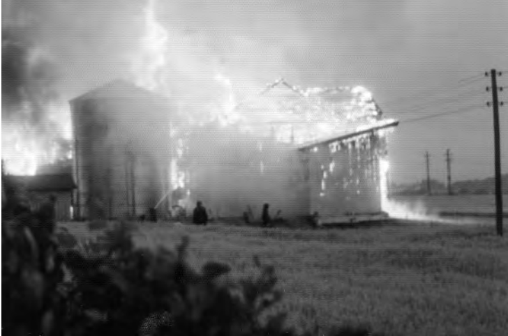
Brannen 13. september 1975. Bildet er utlånt av Johny Nielsen.
