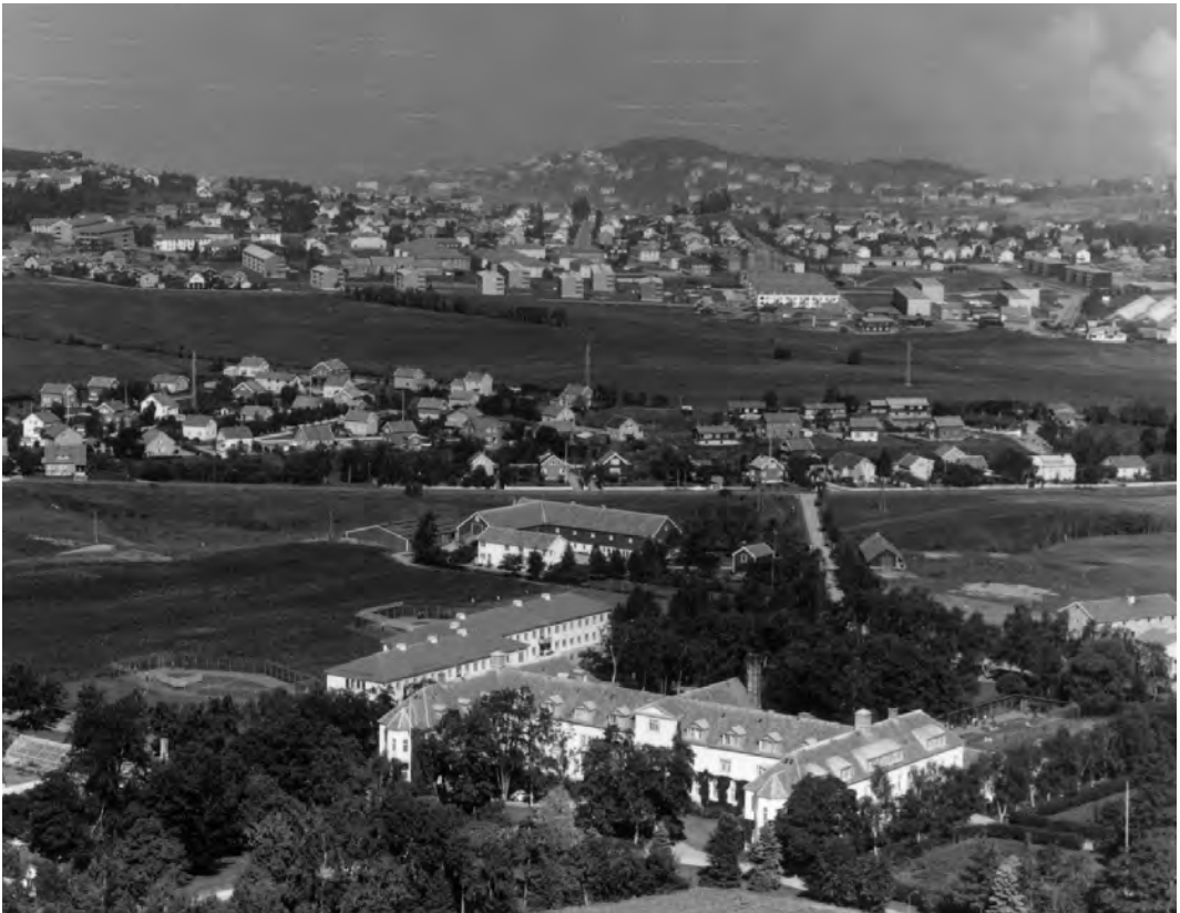
Flyfoto mot nord 5. august 1969. Legg merke til nybygget fra 1961 bak den gamle bygningen. Se også bildet fra 1936 på side 71.
