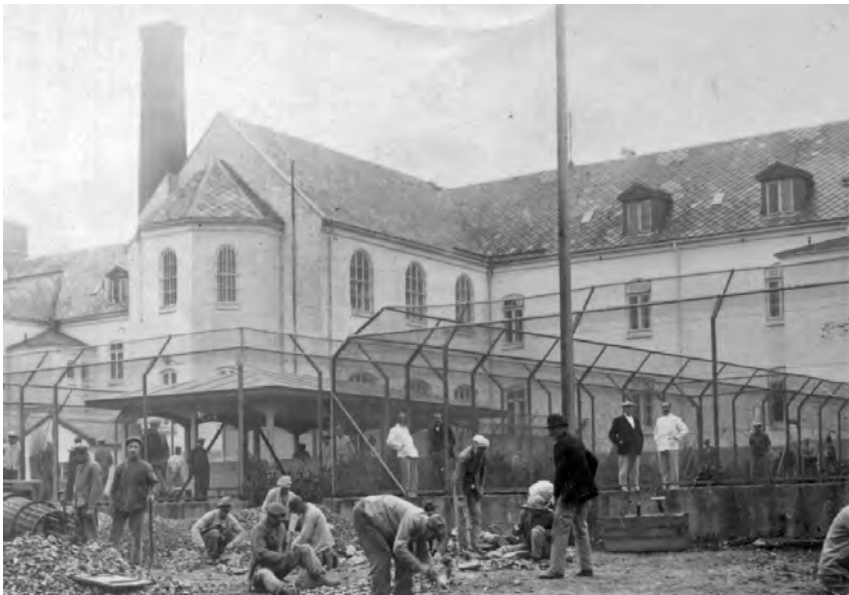
Steinarbeid i ytre luftegård. Stein fra steinbruddet knuses til pukk. Redskapet helt til venstre er sorterings-trommelen. Reitgjerdets kapell er i 2. etasje i utbygget. Bilde utlånt av Anne Marie Johansen.
