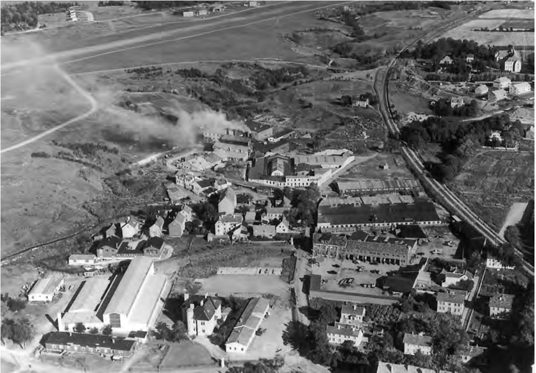
I forgrunnen ser vi Finnes Barnehjem godt innebygget av bygninger tilhørende Bergs Maskin. Bergs Maskin kjøpte Finnes Barnehjem og brukte bygningen til kontorer. Landteknikk kjøpte Bergs Maskin i 1968 (se artikkelen om Landbrukscenteret på Tunga, s. 70). Utsnitt av foto fra 9. juni 1953. Foto: Widerøes Flyveselskap. Kopi fra Universitetsbiblioteket i Trondheim.
