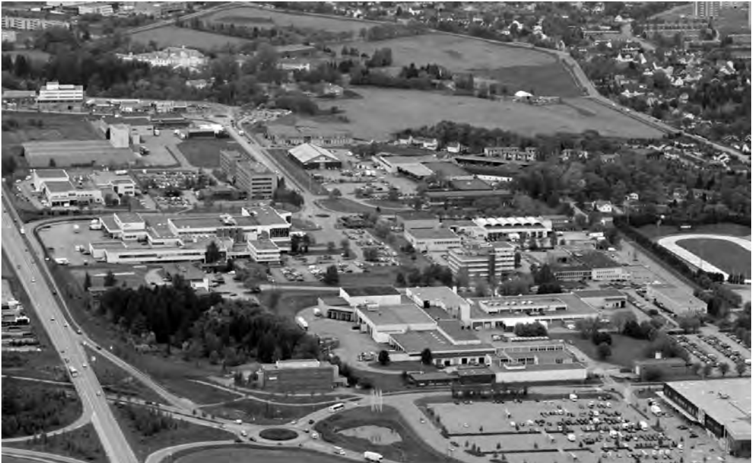
Landbrukssenteret i mai 2006. Mellom Diplom-Is og Felleskjøpet ser vi kontorbyggene til Direktoratet for naturforvaltning (DN) og Norsk institutt for naturforskning (NINA). I forgrunnen til høyre ser vi IKEA og bakerst tidligere Reitgjerdet sykehus. Foto: Morten Antonsen, Adresseavisen.
