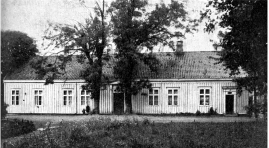
Kapellanboligen etter ombygginga i 1926, da den symmetriske østfasaden ble brutt med ny kjøkkeninngang til høyre. Hovedinngangen var flankert av to asketrær, kjøkkeninngangen på sørgavlen av to hestekastanjer. Bilde fra Strinda bygdebok (1939).
