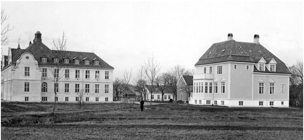
Blindeskolen med bestyrerboligen til høyre. I bakgrunnen ser vi stabburet, kapellanboligen og vaktmesterboligen med taket under reparasjon. Veien foran hovedbygningen er den gamle gårdsveien som gikk opp langs Lerkehaugen til Rønningsbakken. DMMHs arkiv.
