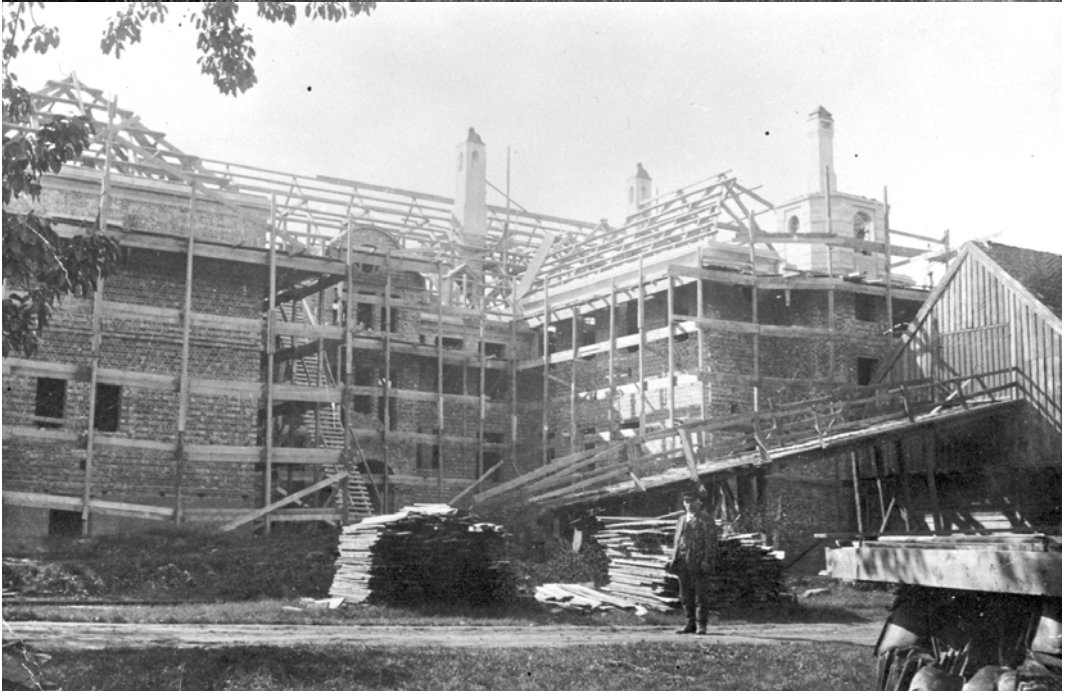
Blindeskolen under oppføring, 1911. Øverst ser vi arkitekt Johan Osnes i forgrunnen. Det nederst bildet viser bygget fra nord. Ennå sto fjøset på sin opprinnelige plass sør for hagen. Under låvebrua var det utedo med låvebrua som tak. Kopi fra Universitetsbiblioteket i Trondheim.
