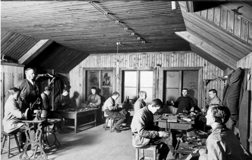
Skomakerverkstedet på loftet i kapellanboligen mot sør. Bildet er udatert, men må være tatt før yrkesskolen ble nedlagt i 1925. Universitetsbiblioteket i Trondheim.
