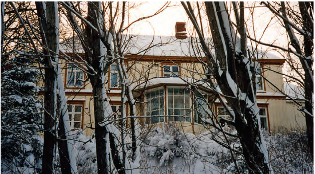
Saxenborg, Rønningsbakken 4. Fasaden mot hagen. Glassverandaen ble påbygd i 1890-årene. Foto: Harald Carstens.
