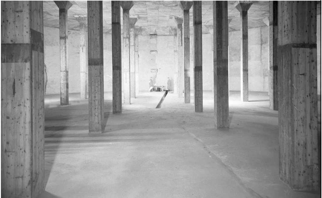
Vannmagasinet fra krigens tid innvendig. Dette ble overtatt av Trondheim kommune etter krigen og er nå "Kuhaugen høydebasseng" og fortsatt i bruk. Det ligger sør for bunkeren. Fram til 1964 kom vannet fra Bymarka - senere fra Jonsvatnet. Foto: Schrøder. Utlånt av Jørn Nikolaysen.
