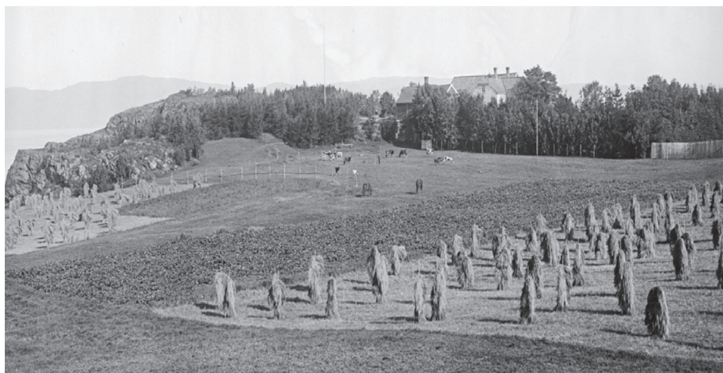
Østmarken sett fra sør i 1903. Bildet viser tydelig omrisset av den store hagen. Leiv Erikssons veg går i dag over jordet og inn i hagen omlag ved den lyse stolpen. De to bildene av gården tatt fra motsatte sider viser at det i alle fall var 5 hus på gården. At eieren Jon Ofstad hadde inntekter utenom gården, er ganske tydelig om det er hele buskapen man ser på bildet. To hester beiter på jordet. Foto: E. Olsen. Kopi fra Universitetsbiblioteket i Trondheim.
