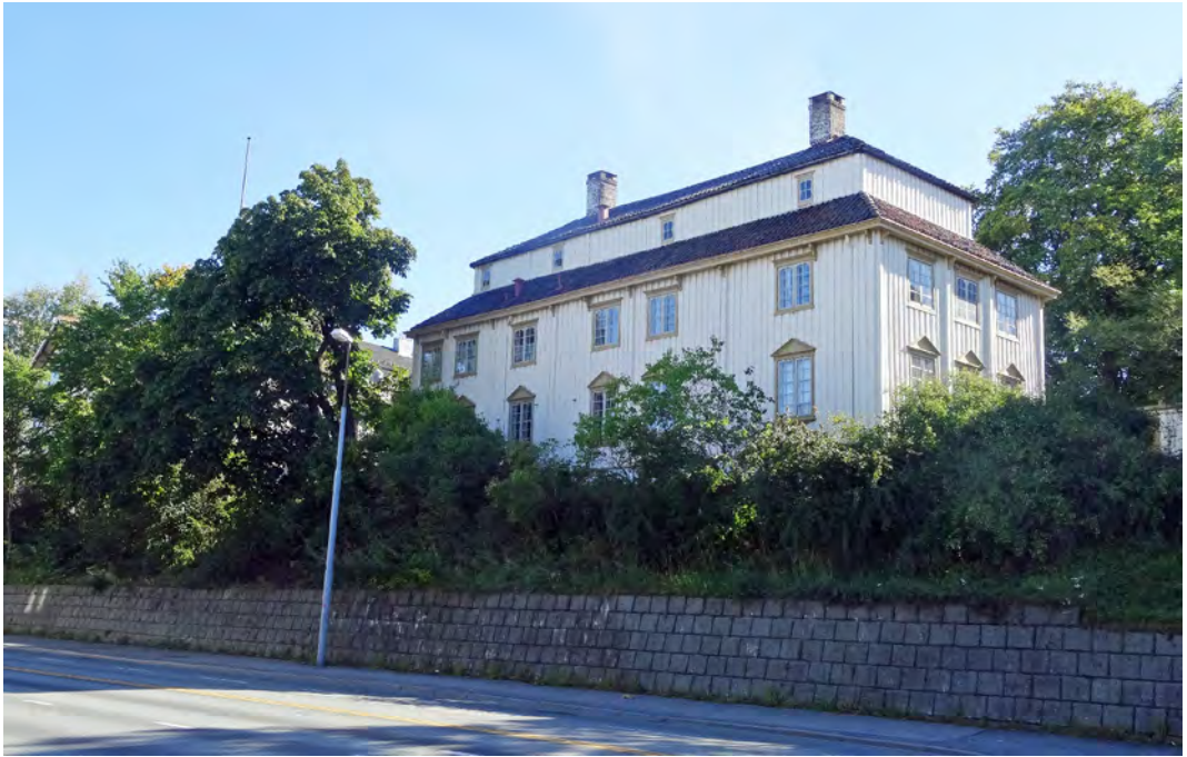
Bakke gård (Innherredsveien 3) i dag sett fra Innherredsveien. Under huset er det ruiner etter klosterkirken. Resten av klosteranlegget lå bak huset. Foto: Knut L. Vik.
