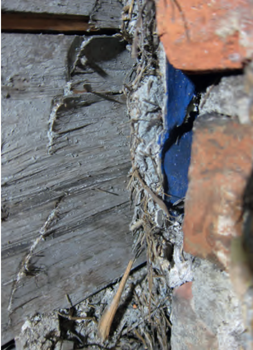
Tapetrest på rapping som ble funnet på veggen bak brannmur i 2. etasje. Foto Edwin Verweij, NIKU.
