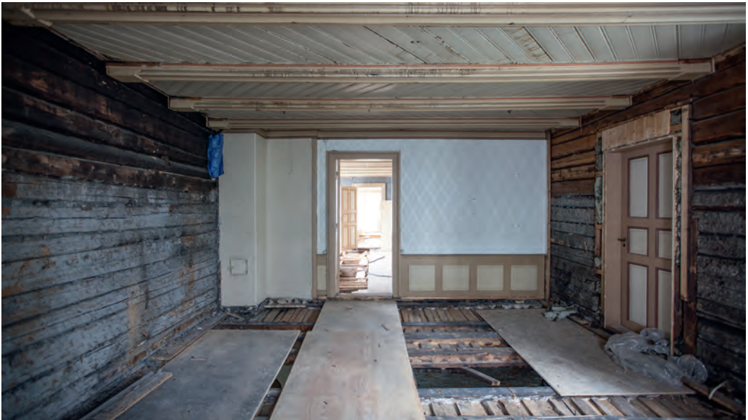
I 2. etasje var de øverste tømmerstokkene av en helt annen karakter, og hadde ikke rester etter skavhogst og rapping. Foto: Edwin Verweij, NIKU (2016).
