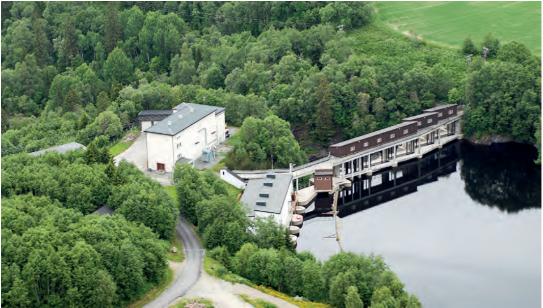
Fjæremfossen kraftverk. Den gule bygningen er koblingshuset, selve kraftstasjonen ligger i fjell. Foto: Mikal Sveen, Statkraft Trondheim.
