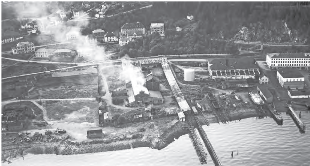
Ila smelteverk ca. 1936. Til venstre for smelteverket ser vi Ilsvikøra og til høyre Ila Slip, eid av Ørens Mekaniske Verksted. Helt til høyre ligger Norges Kooperative Landsforenings lager. A/S Ila og Lilleby Smelteverker eide Ørens Mekaniske verksted i perioden 1960 – 1987, og også Trolla Brug mellom 1974 og 1983. Foto: Widerøes flyveselskap/NTNU UB.
