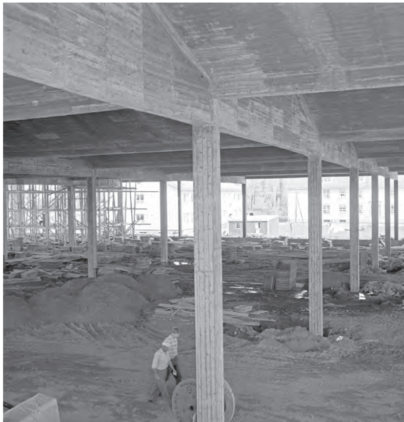
KØFFs lagerhall under bygging i 1961. Det var høyt under taket. Foto: Schrøder/Sverresborg Trøndelag Folkemuseum.
