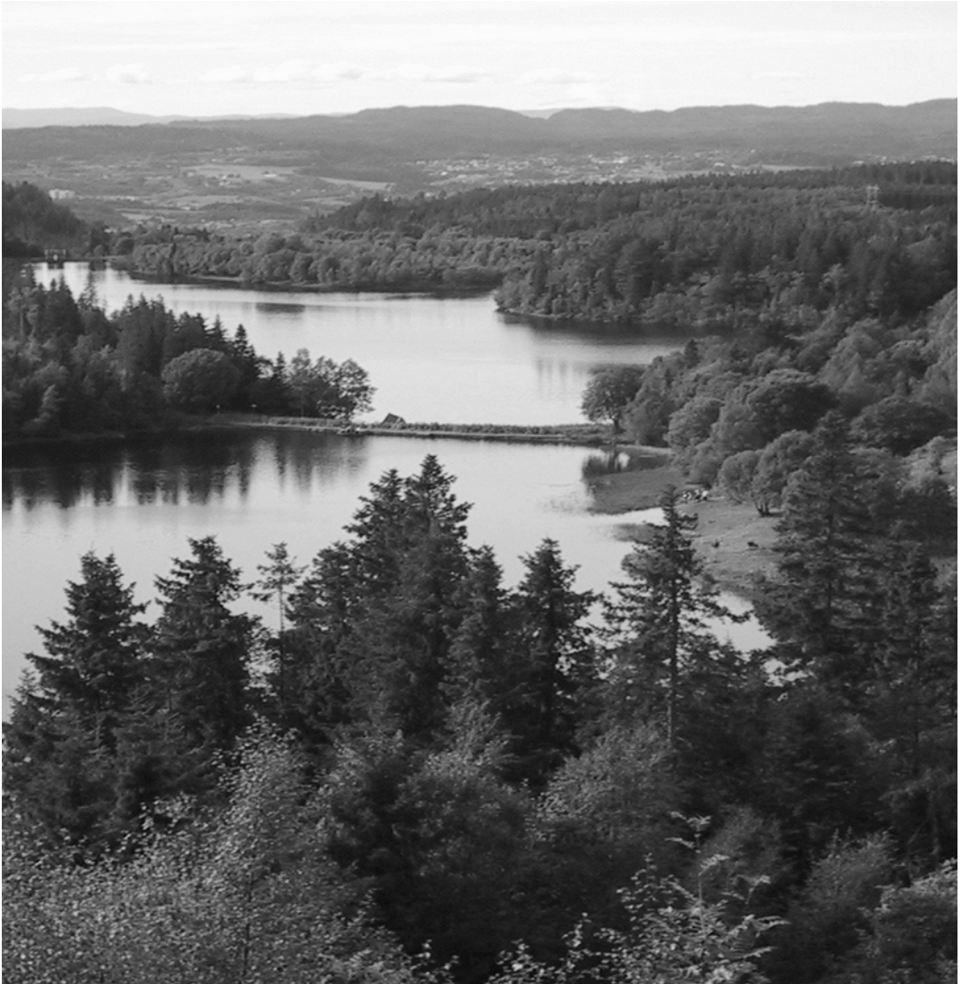
Estenstaddammen og Tømmerholddammen i september 2001. Estenstaddammen er nærmest. Tuftene etter Estenstad gård vises til høyre i bildet.
