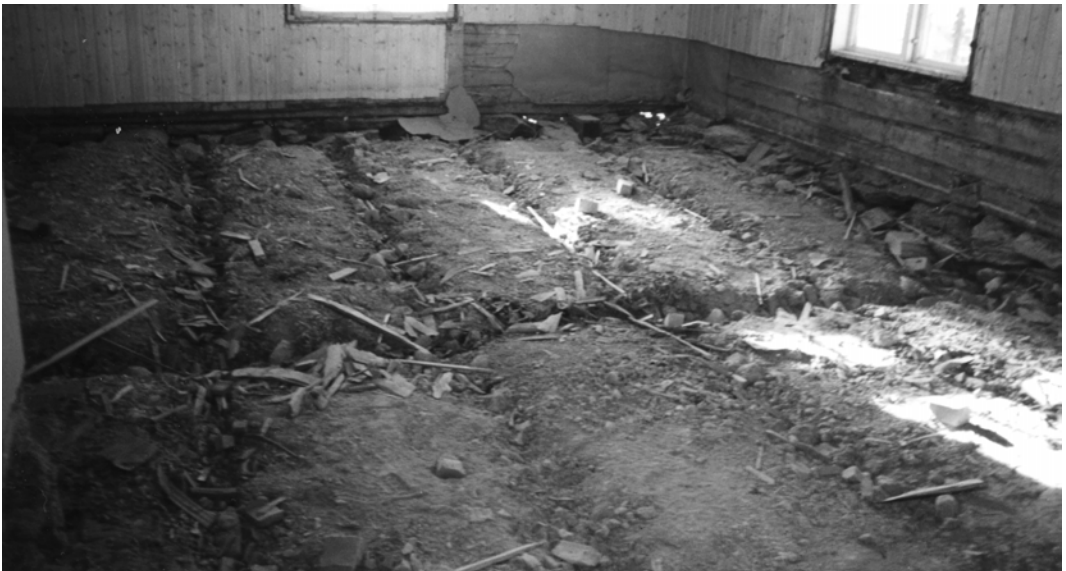
Bilde fra vestfløyen (bygget fra 1881). Gulvet er fjernet, og vi ser jordgulvet med merkene etter bjelkene som lå rett på bakken og den dårlige grunnmuren. Foto: Bjarne Gjerding.
