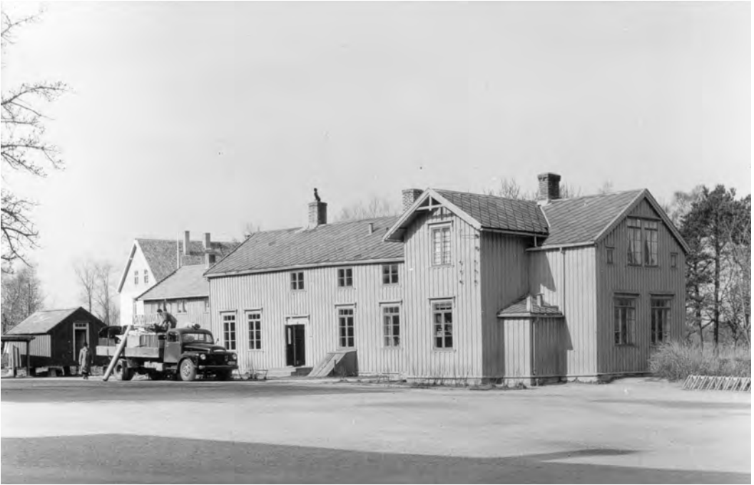
Skolebygningen fra 1895 ("Gulbygget") ca 1960. Venstre del av bygningen var lærerleilighet med stue, kjøkken og ett rom i 1. etasje, og 2 soverom, bad og tørkeloft i 2. etasje. Utbygget til høyre var et trappehus. I denne enden var det 2 klasserom i 1. etasje og leilighet i 2. etasje. Denne leiligheten var prestekontor i 1960-årene. Foto: Karl Fjæran. Bilde utlånt av Gunnar Fjæran.
