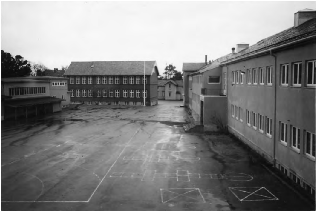
Skolegården før riving og ombygging. Bakerst er "Gulbygget". Foran det er bygget fra 1914 slik det ble etter påbyggingen i 1924. Bygningen til venstre er gymnastikksalen fra 1938 og til høyre er bygget fra 1953.
