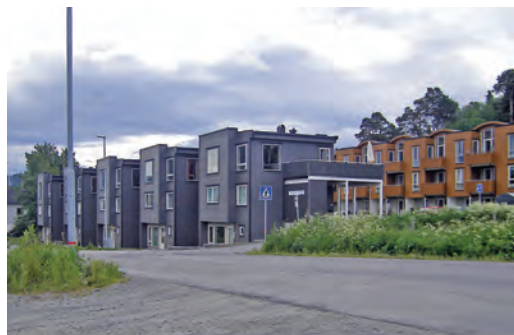
Ranheimsvegen 75 i 2009. Det er nå 15 rekkehus på tomter der Gaute fabrikk holdt til i 57 år. Foto: Roar Tøndel.
